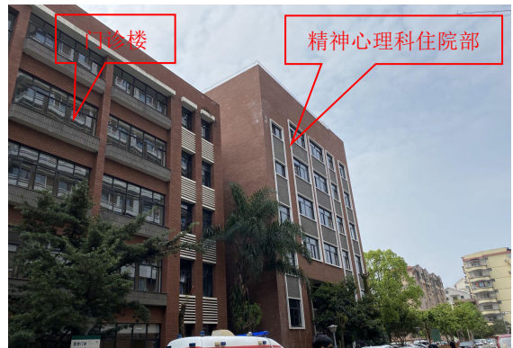
第二综合楼西南侧门诊楼、精神心理科住院部
